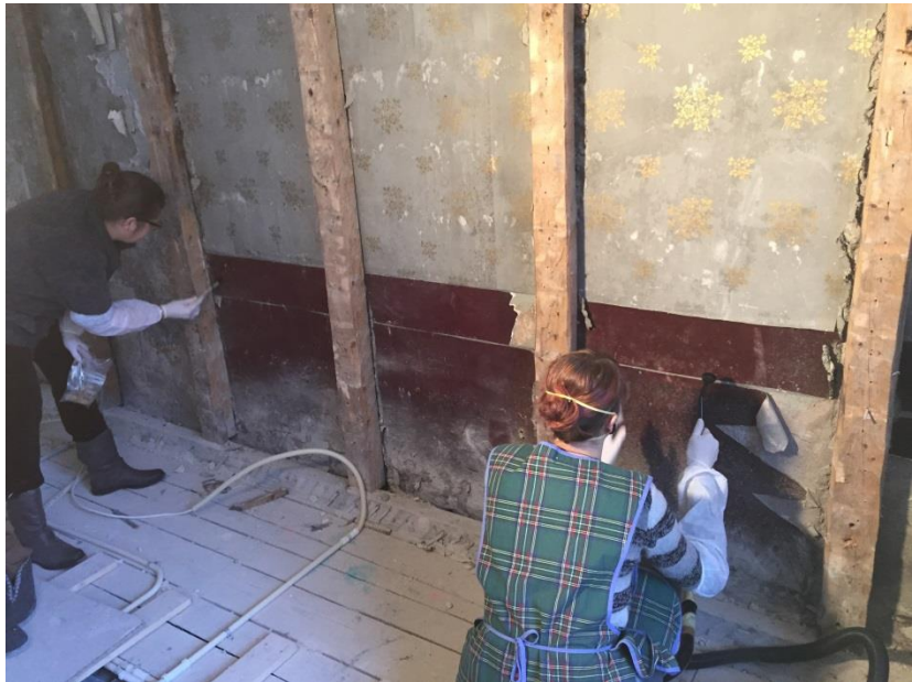
Ehitustolmust ja hallitusest puhastamine
