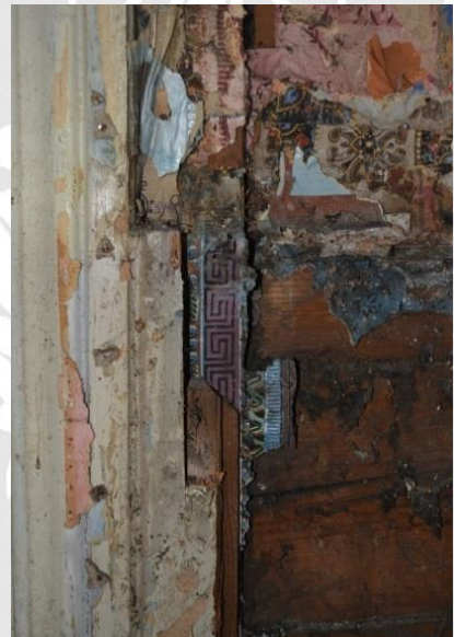
Ehitusaegse bordüüri peale paigaldatud hilisem ukse piirdeliist, Poska 35, Tallinn
