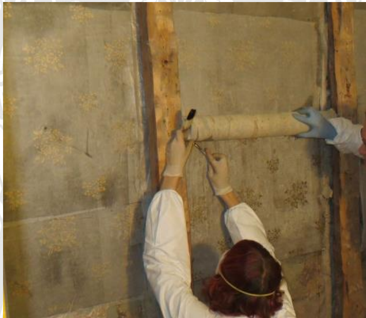
Tapeedi eemaldamine seinast
